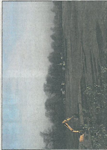
Izkop humusa na trasi visokovodnega nasipa gorvodno od zgradbe HE na levem bregu Save
